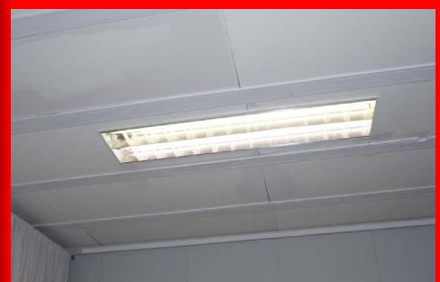
De inbouwarmatuur uitgevoerd met de nieuwe LED-tube verlichting
