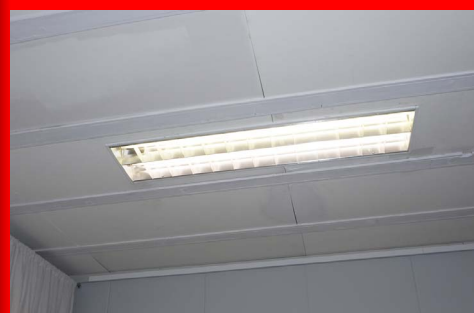
De inbouwarmatuur uitgevoerd met de nieuwe LED-tube verlichting
